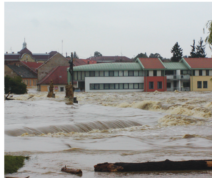
Obr. 13. Voda ničivá I – při povodni v jihočeském Písku roku 2002 vyčuhují z přelitého mostu jedině sochy světců Zdroj: www-cs-wikipedia.org
